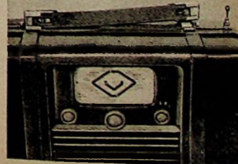
Bild 3. Traggriffkonstruktion, die eine schnelle Abnahme der Rückwand gestattet
